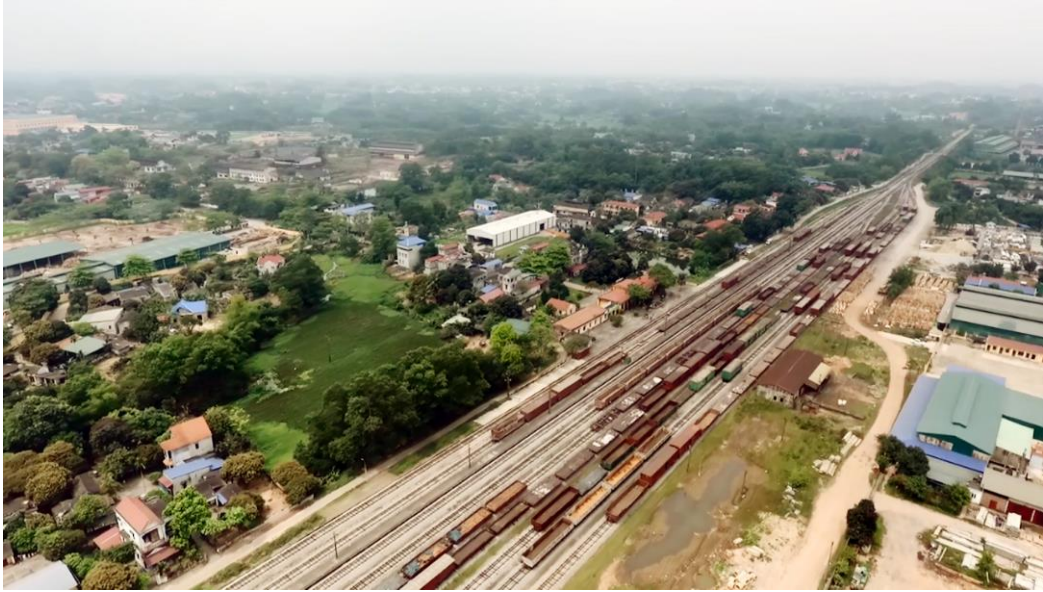
Đường sắt Thái Nguyên - Hà Nội (tại Ga Lưu Xá, thành phố Thái Nguyên).
